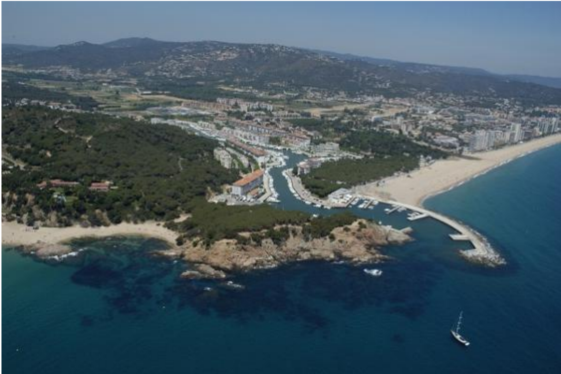
Aspecte actual de l'espigó de Port d'Aro
